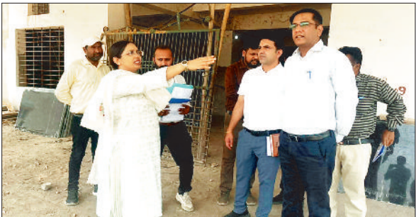
निर्माणाधीन अस्पताल का निरीक्षण करती कलेक्टर रोजिता यादव।
